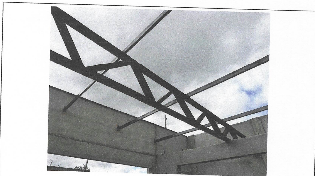
FOTO 66: ESTRUTURA COBERTURA METÁLICA
