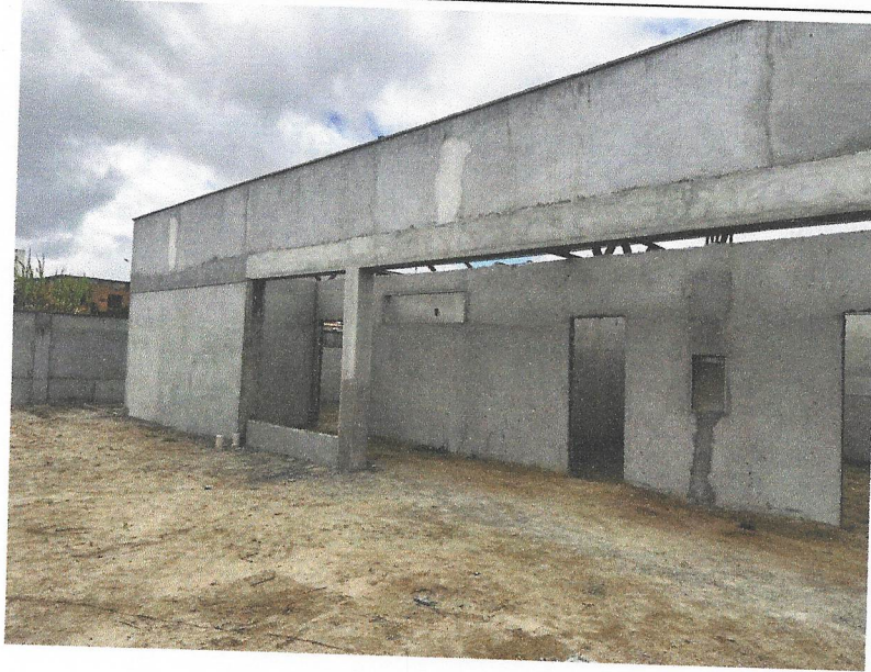
FOTO 67: REBOCO E PINGADEIRA
