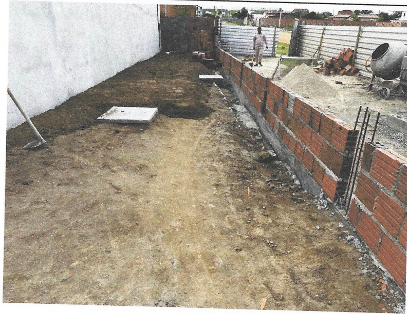
FOTO 79: LEVANTE DE ALVENARIA MURETA
