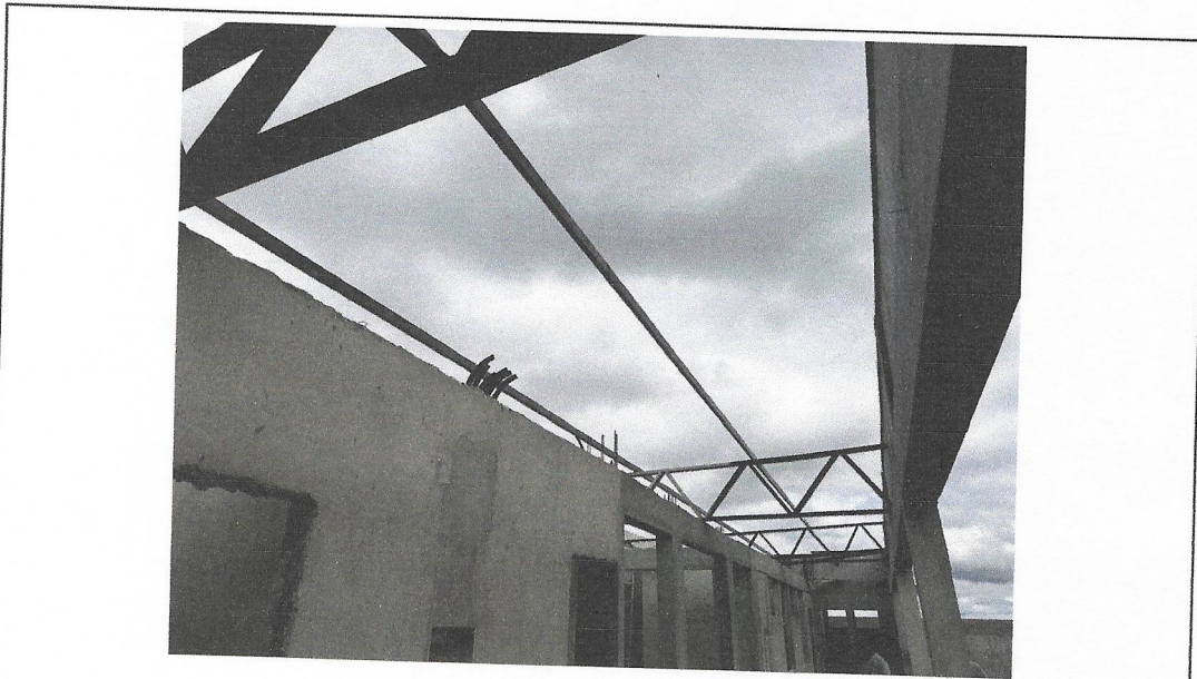
FOTO 65: ESTRUTURA COBERTURA METÁLICA
