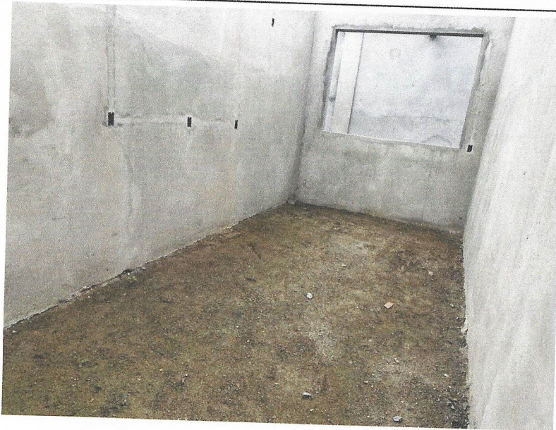
FOTO 68: REBOCO E INSTALAÇÃO DE CAIXAS ELÉTRICAS
