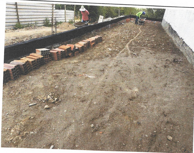
FOTO 78: IMPERMEABILIZAÇÃO DE VIGA BALDRAME - MURETA
